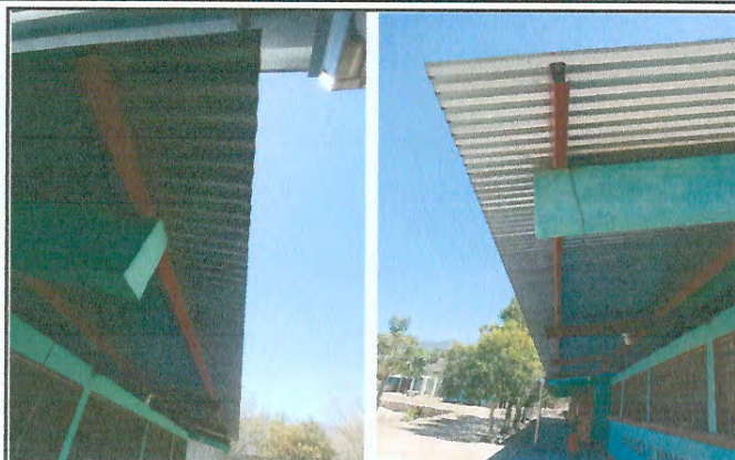
Foto 2 y 3: Mejoramiento de canales y bajada de agua pluvial en módulos de Preprimaria.
